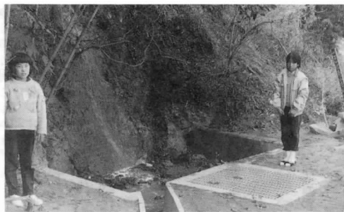
完成したなべ坂の排水溝
