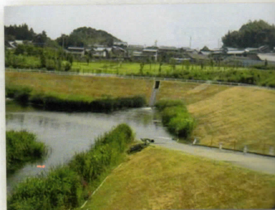
新小山最終処分場内の調整池
